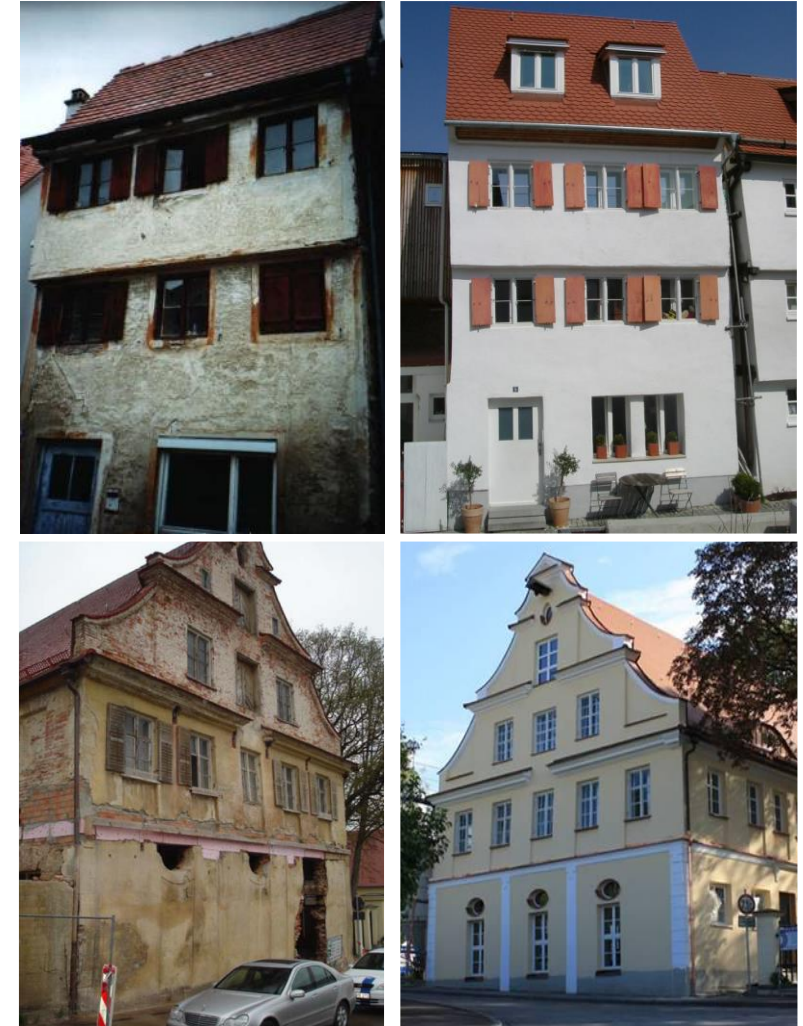
Sanierungen zum Passivhaus, Arch.: Martin Endhardt
