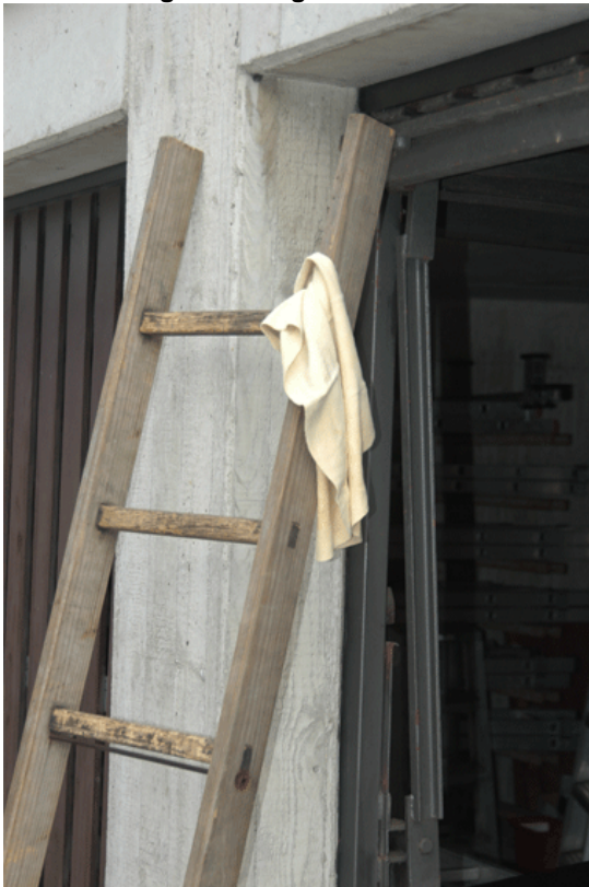
Bild: Unsachgemäß aufgestellte Leiter
