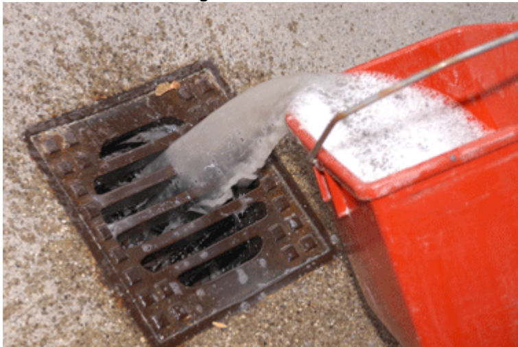
Bild: Schmutzflotte im Regenwasserkanal
